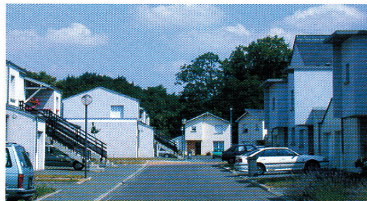
Voies secondaires [Photo 1]
