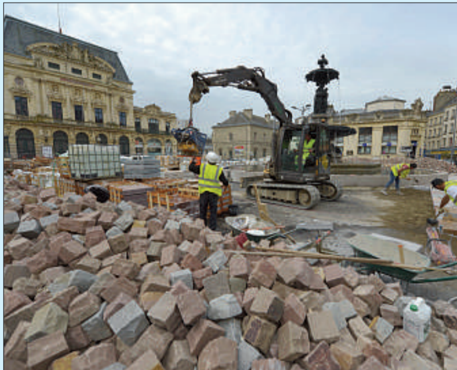
Les travaux dans le centre-ville de Cherbourg vont évidemment entraîner des perturbations au niveau du stationnement et de la circulation.
