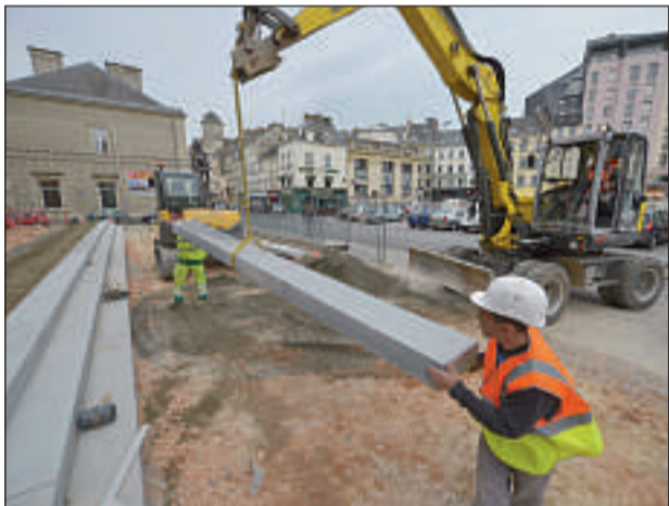
Les premières marches en granit ont été posées sur le parvis du théâtre.
