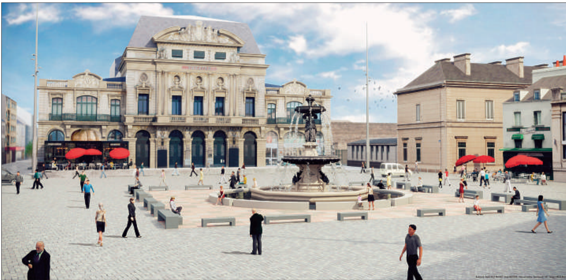
Une vue de la place De-Gaulle une fois les travaux terminés.
