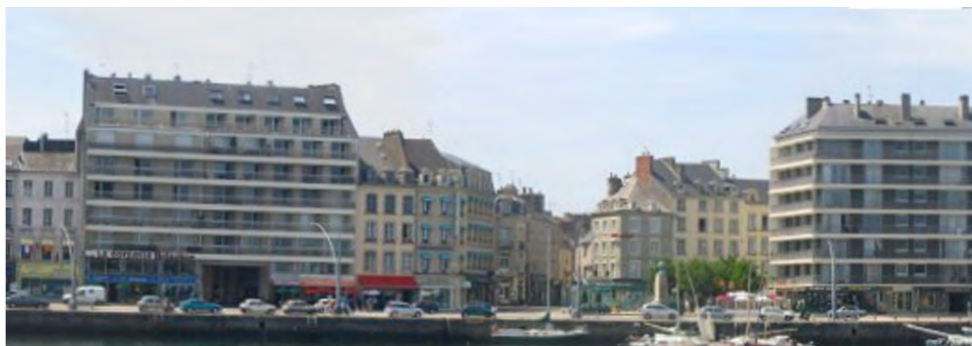
Mauvais exemple de façade avec les balcons filants
