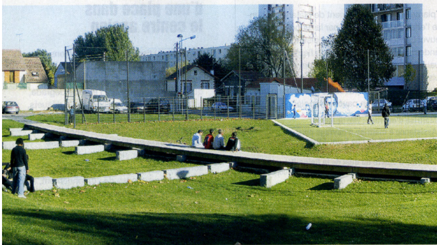
Une passerelle de bois reposant sur des blocs de granit enjambe le bassin d'infiltration des eaux pluviales. A l'arrière-plan, les nouveaux terrains de sport.
