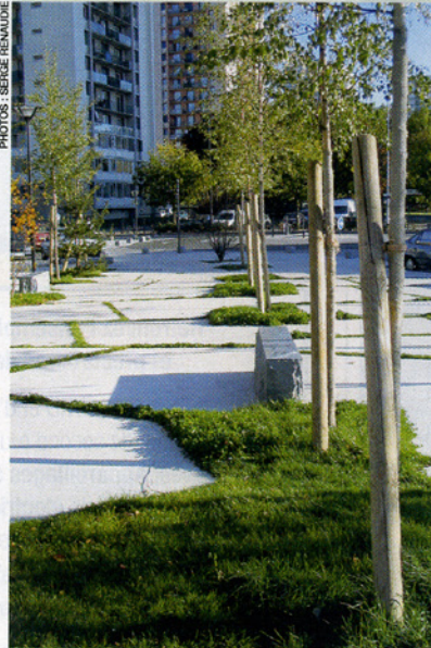
Le long de la grande prairie et des jardins, les mails sont réalisés en plaques de béton balayé, séparées par des bandes de trèfles plantés.
